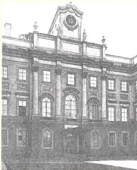
Рис. 1. Часть двора перед восточным фасадом. Фото 1910-х гг. (Воспроизв. в кн.: И. Грабарь, История русского искусства. М., [1912]. Т. III. С. 299) Крыльцо главного входа оснащено бюрловским козырьком. Плитный тротуар по периметру двора огражден чугунными тумбами с цепями. Двор замощен булыжником.
